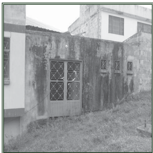
En estas y en la siguientes fotografías se observa la humedad y el estado inconcluso de la obra
